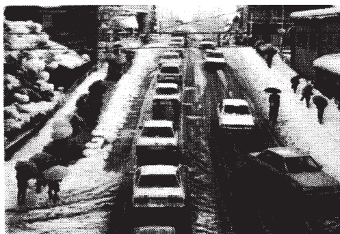
写真7-2 地下水再利用（歩道無散水、車道散水）の融雪
