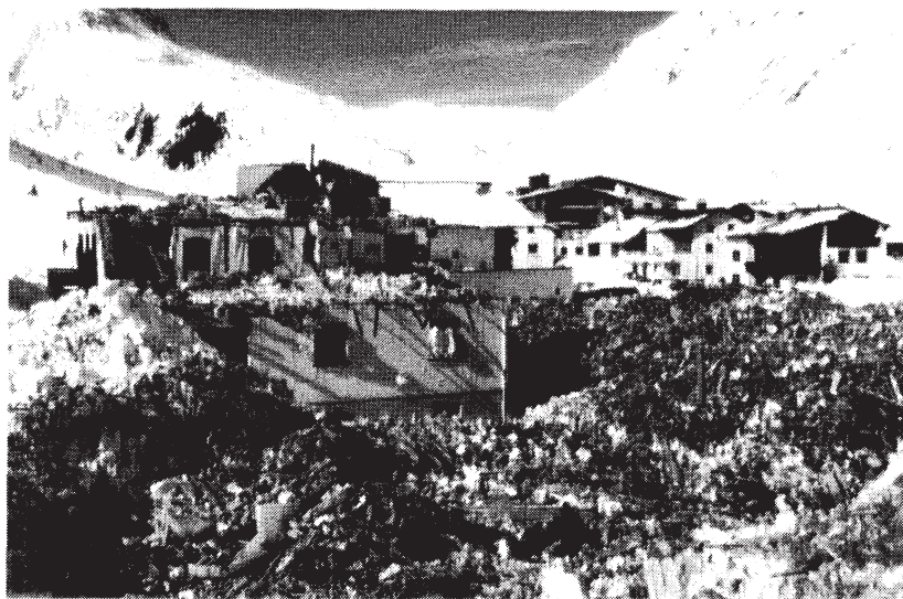
写真 8-1 パツナウン谷ガルテュア村の建物の被害状況 (死者 31 名) (写真提供：イン川上流工事事務所/1999 年 2 月撮影)
