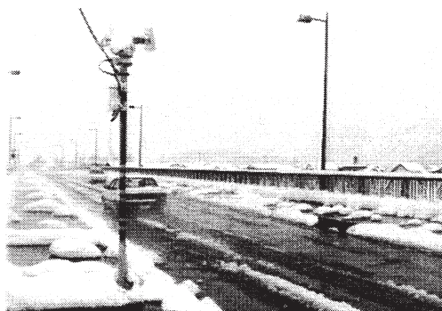
写真7-1 融雪を制御する積雪センサー
