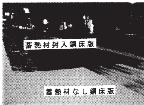
写真7-4 蓄熱材封入鋼床版橋の降雪時の効果
