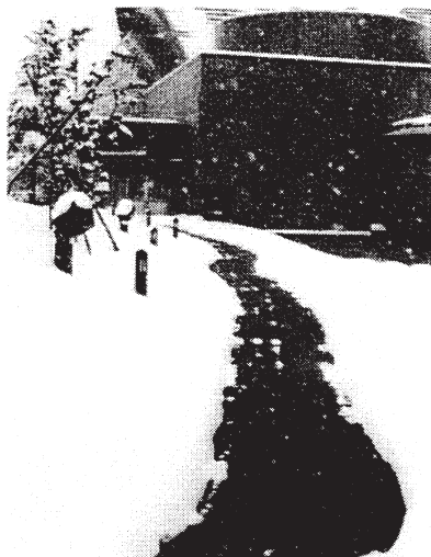
写真7-3 基礎杭で地中熱を集熱しての融雪
