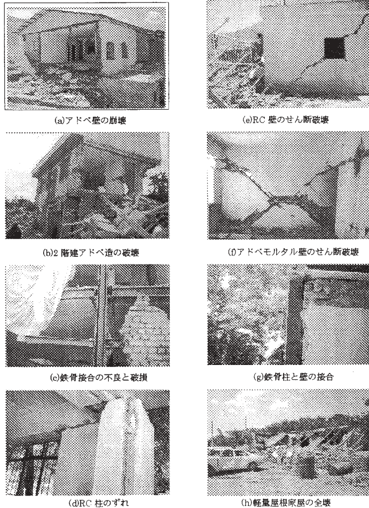
写真3 建物被害の様子
