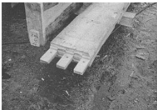
写真3-4-2 大断面の横架材と仕口部の丁寧な仕事
