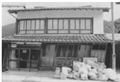
写真3-4-1 日野町黒坂地区の住宅と被害
