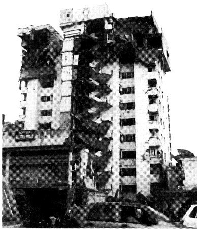
写真3 高層アパートの崩壊(写真に見える高層アパートと同タイプの高層棟が手前にあったが、完全に崩壊した。Ahmedabadにて)
