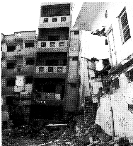
写真4 6階RC造・プロティの崩壊(Bhujにて)
