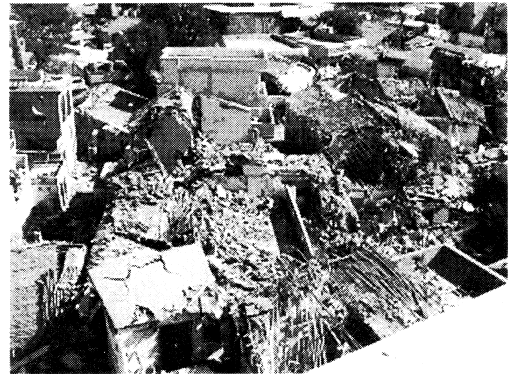
写真5 建物の屋上から見た光景(Bhujにて)
