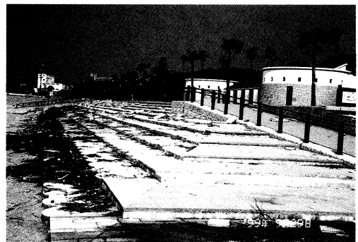
写真 5 小野田市焼野⑥における護岸の損壊
