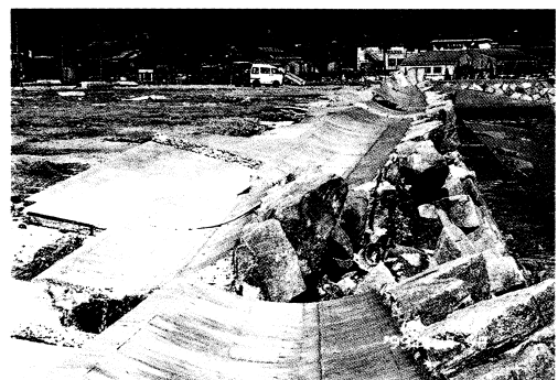
写真16 秋穂町北条⑥におけるパラペットの倒壊
