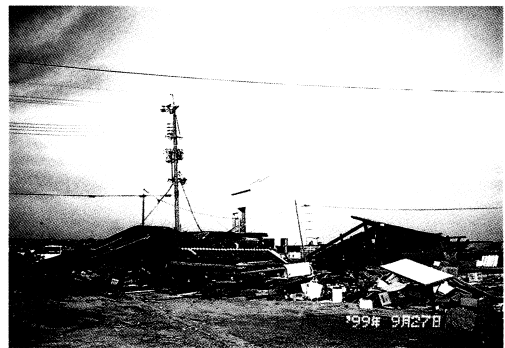
写真 10 宇部市西岐波床波⑮における水産加工工場⑮の倒壊
