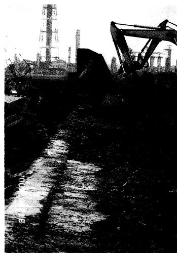
写真 8 小野田市西沖⑧における新規護岸建造のために行われている護岸の解体状況（平成 12 年 6 月 21 日撮影）
