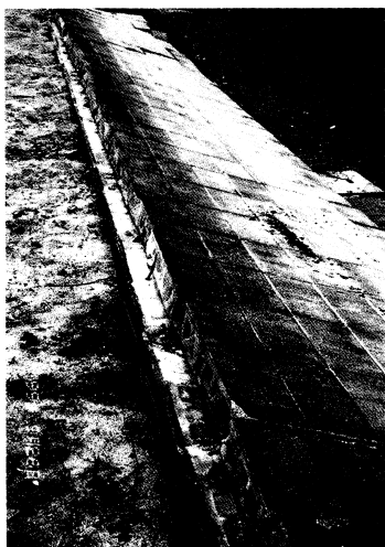
写真12 宇部市岐波⑩におけるブロック塀の倒壊
