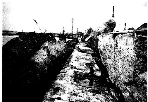
写真 7 小野田市西沖⑧におけるパラベットの倒壊
