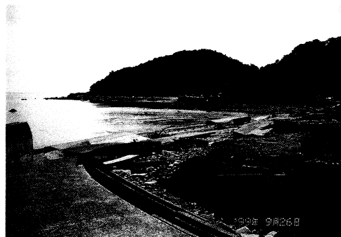
写真15 秋穂町岩屋⑤におけるパラペットおよびアスファルト舗装道路の破損
