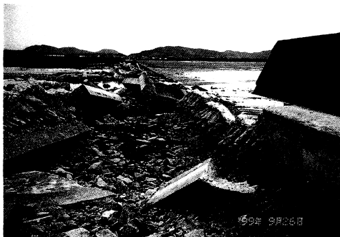
写真14 山口市秋穂二島④における決壊した堤防
