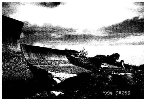
写真1 山陽町植生①における護岸の損壊
