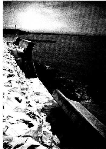
写真 9 宇部市沖宇部⑬におけるパラペットの倒壊
