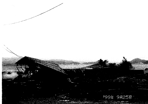
写真4 山陽町津布田②における倉庫の被災
