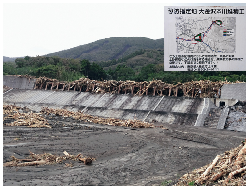
写真9 大金沢本川堆積工における流木の捕獲と砂防指定地を提示した看板
