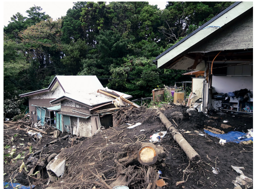
写真6 神達地区における建屋の被害状況
