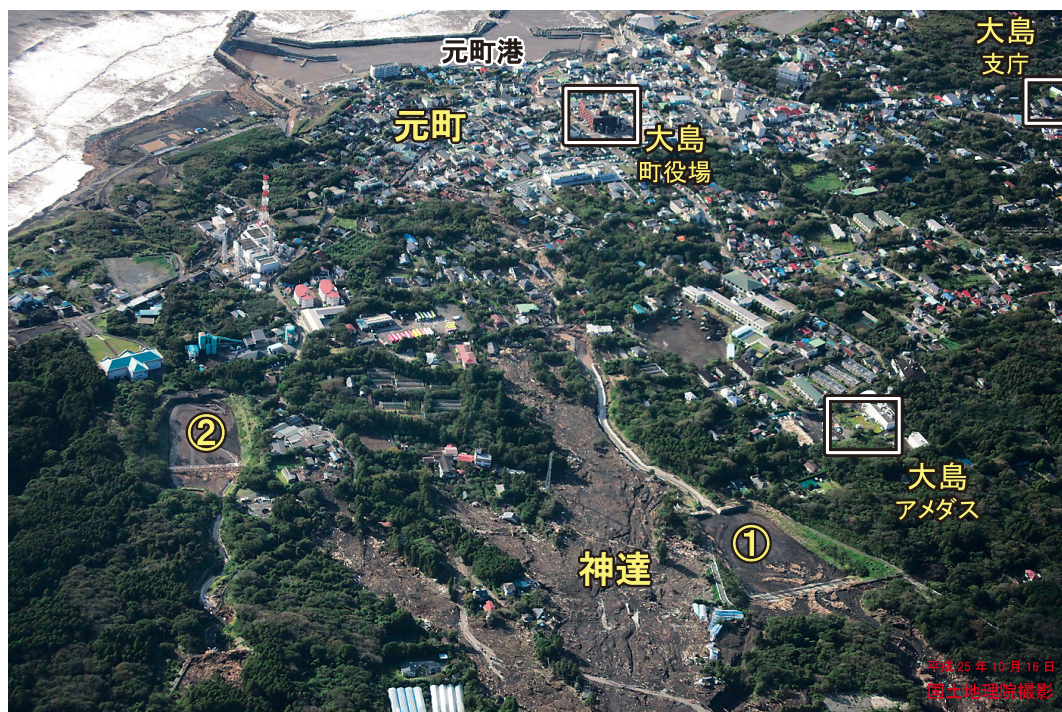
写真1 伊豆大島元町地区で発生した土砂災害の状況（国土地理院，2013に加筆） (①は大金沢本川堆積工，②は八重沢堆積工，写真中の数字は写真番号と一致)
