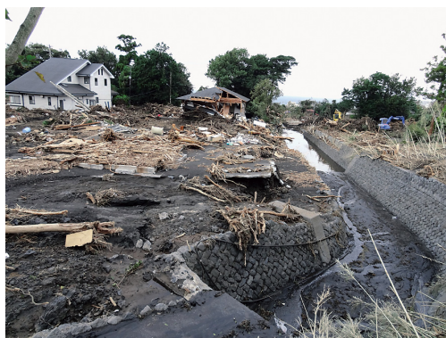
写真12 神達地区における土砂流による家屋の流失、破損の状況
