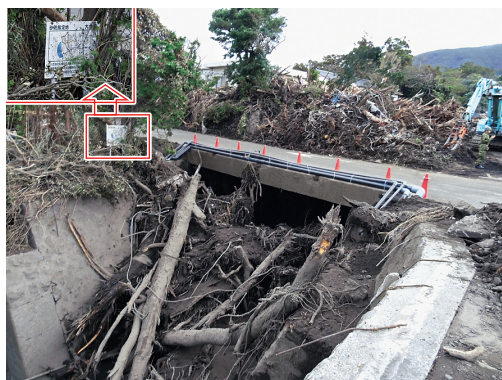
写真11 大金沢の中流に架かる丸塚橋における流木の閉塞状況
