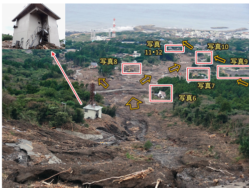
写真5 土砂流の上流から見た中下流の被害状況
