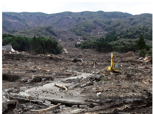
写真8 神達地区の中央部から土砂流が発生した山体を見た流下状況
