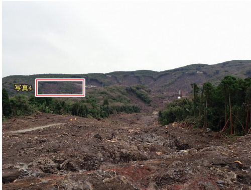
写真3 土石流の上流から見た山体の斜面崩壊の状況
