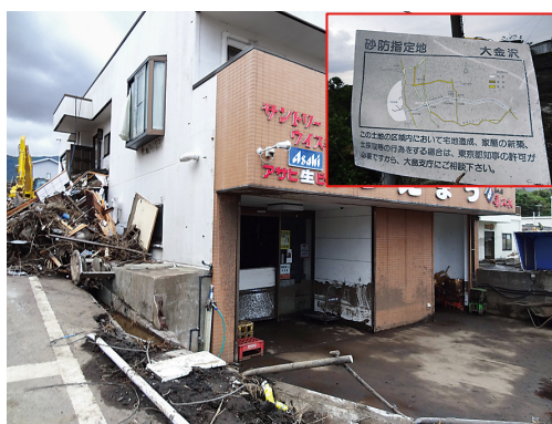
写真13 元町地区の外周道路と大金沢が交差した地点に位置する店舗の被害状況、近接の大金沢橋梁の立てられた砂防指定地の掲示
