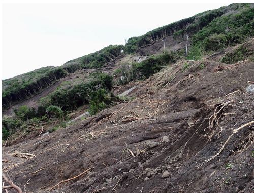
写真4 土砂流の上流における山体の斜面（約25°の勾配）崩壊の状況
