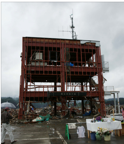
写真2 南三陸町の災害対策棟
