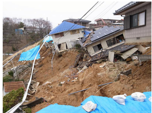
写真1 福島市あさひ台における谷埋め盛土地すべり
