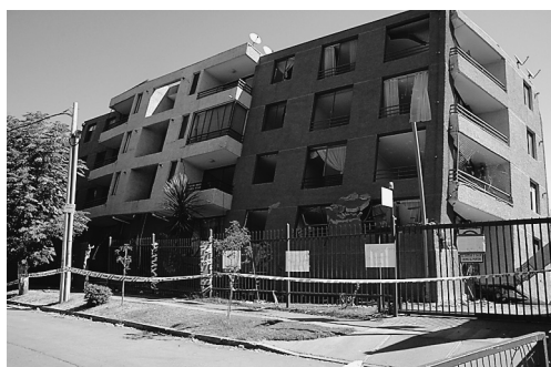
写真9 サンチャゴ市内のアパートの倒壊
