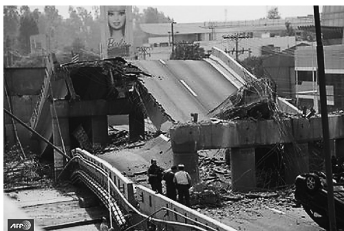
写真2 サンチャゴの環状高速道路橋の橋桁の崩落 (写真:AFP)
