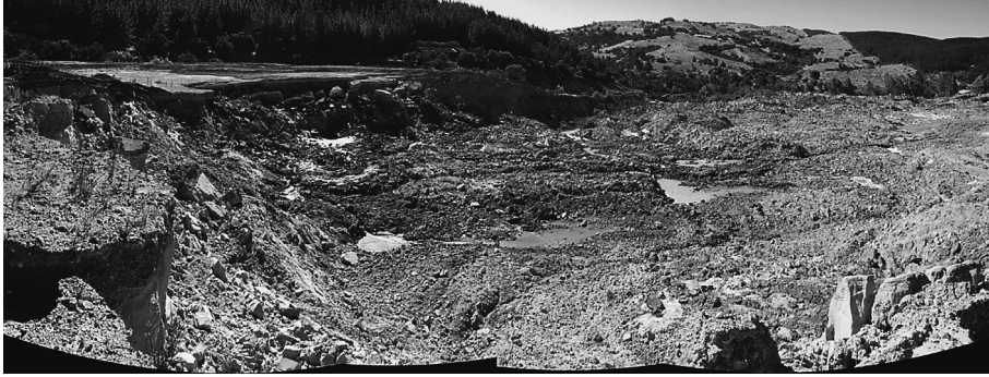
写真8 ラス・パルマスの鉱さい堆積場の滑落崖と下流の崩壊状況
