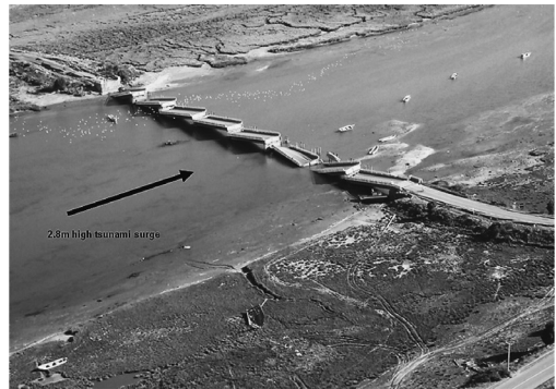
写真5 Tubul 橋の落橋状況
