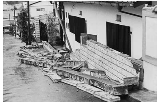
写真3 ブロック塀の倒壊
