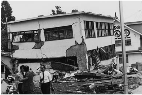
写真1 鉄筋コンクリート造建物の倒壊
